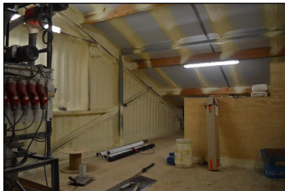
Afbeelding 2.11. Binnenzijde dak actieve stal, welke met purschuim is dichtgemaakt.
