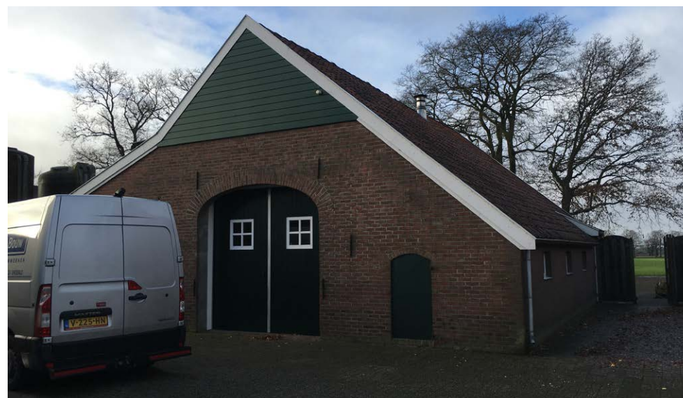
Afbeelding: Schuur in gebruik als werkruimte bouwbedrijf (te behouden)
