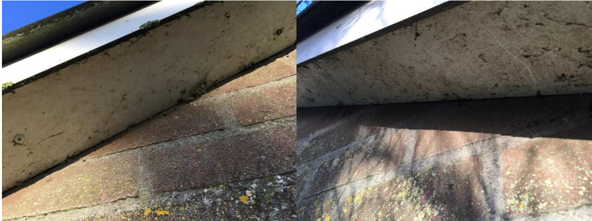
De betimmering van het dakoverstek sluit naadloos aan op de buitengevels.
