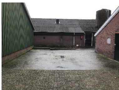
foto 1 - beton- en klinkerverharding
