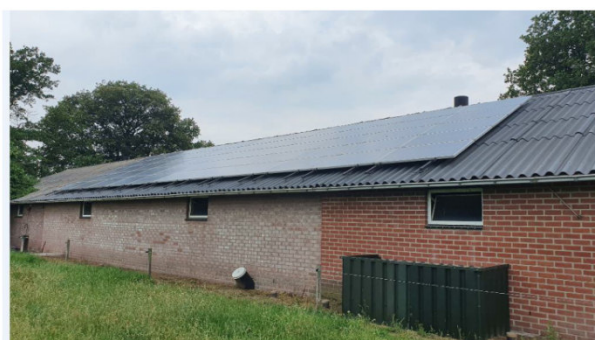
Varkensschuur met dakgoten
