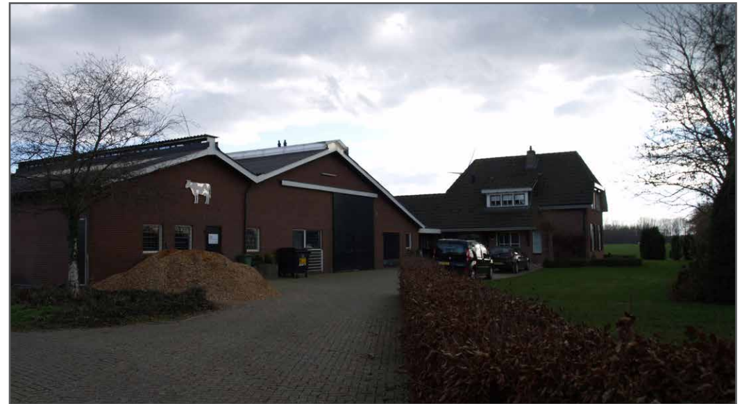
Foto: woonhuis 2 met een van de te slopen schuren
