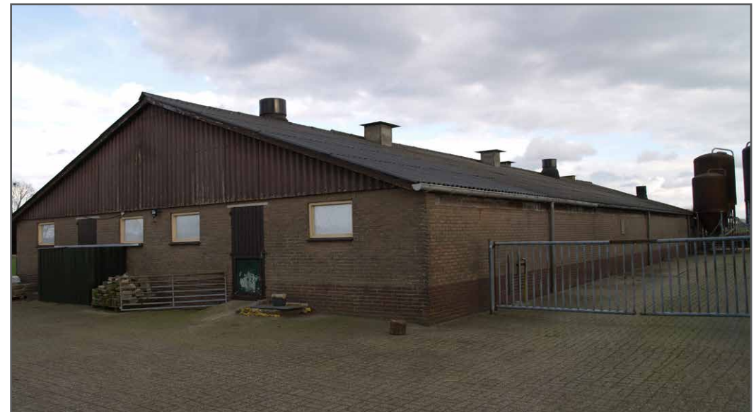
Foto: te slopen schuur
