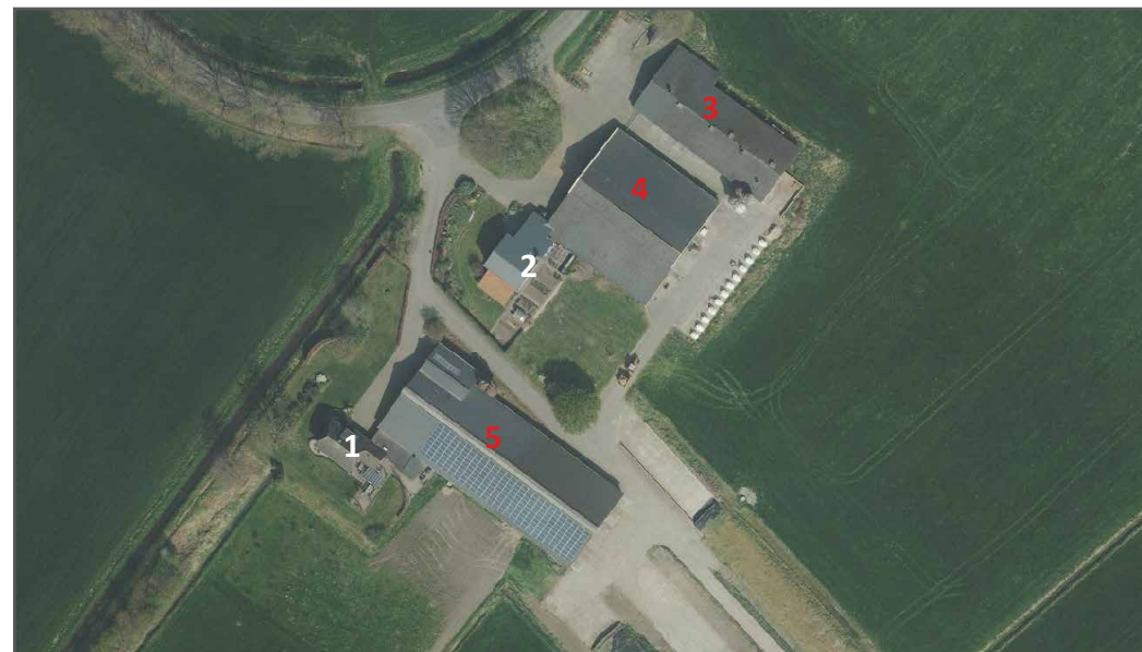
Afbeelding: Huidige bebouwing, te slopen bebouwing rood gemarkeerd.
