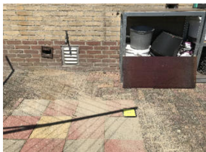
Foto 5 – vml. ondergrondse tank
