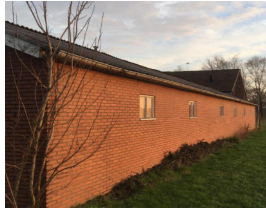
Schuur met dakgoten
