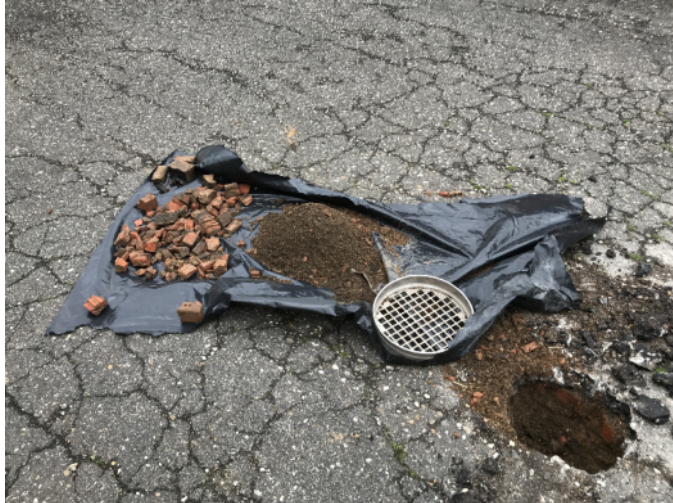
Puinfundatie onder asfaltverharding
