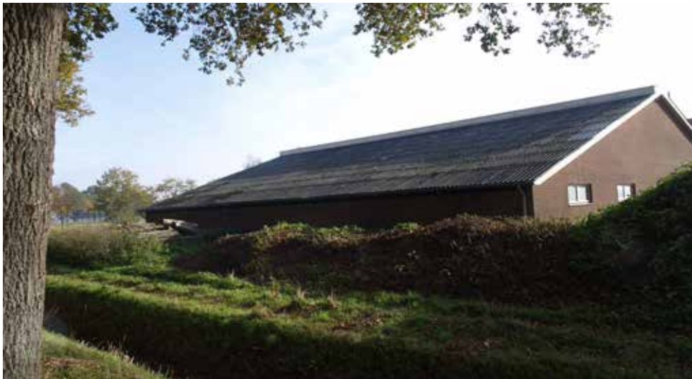
Afbeelding: Te slopen bebouwing.
