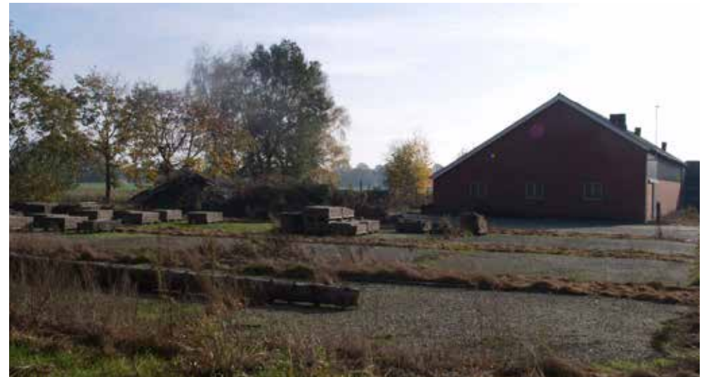
Afbeelding: Te slopen bebouwing.
