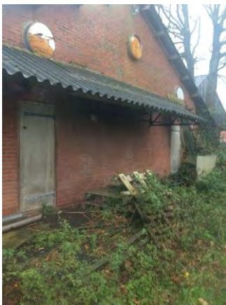
Figuur 8: Overzichtsfoto bebouwing
