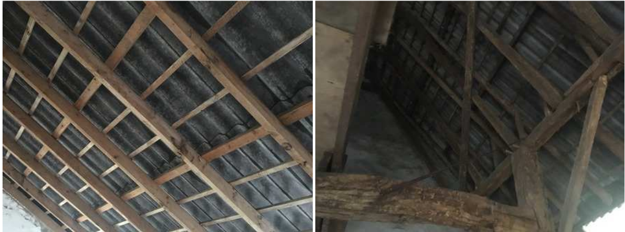
Detailopname van het dakvlak van de schuur; geen beschoten kap.
