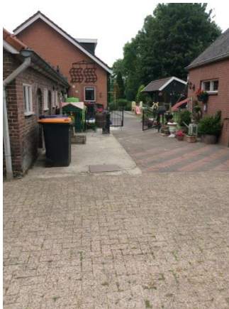
Figuur 8: Overzichtsfoto bebouwing
