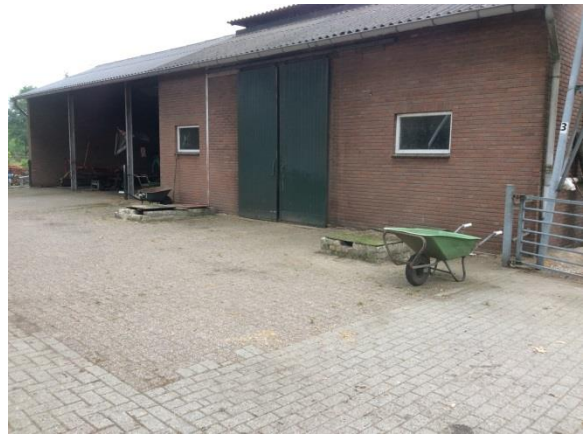
Figuur 9: Dak(goot) bebouwing
