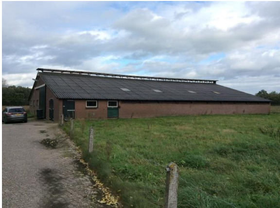
Figuur 8: Overzichtsfoto bebouwing
