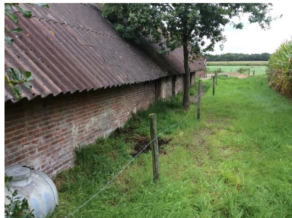
Figuur 9: Dak bebouwing
