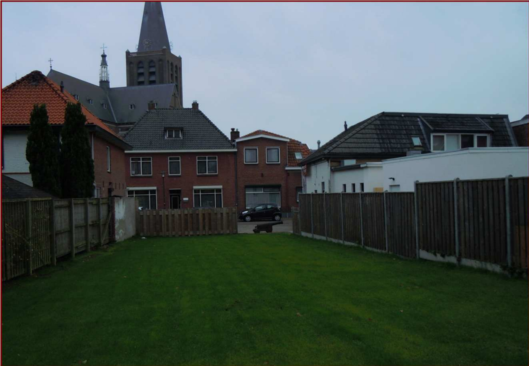
S.12.243.00 Nieuwstad 7 te Groenlo (Café Kras: zuidgevel)
