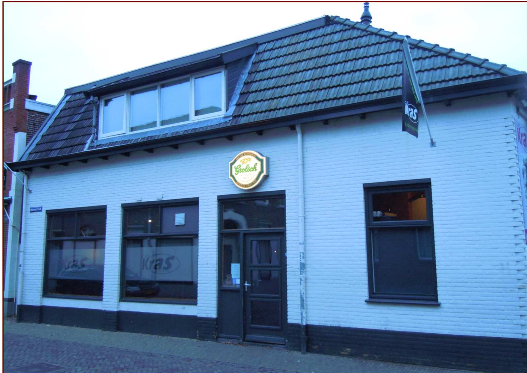
S.12.243.00 Nieuwstad 7 te Groenlo (Café Kras: westgevel)
