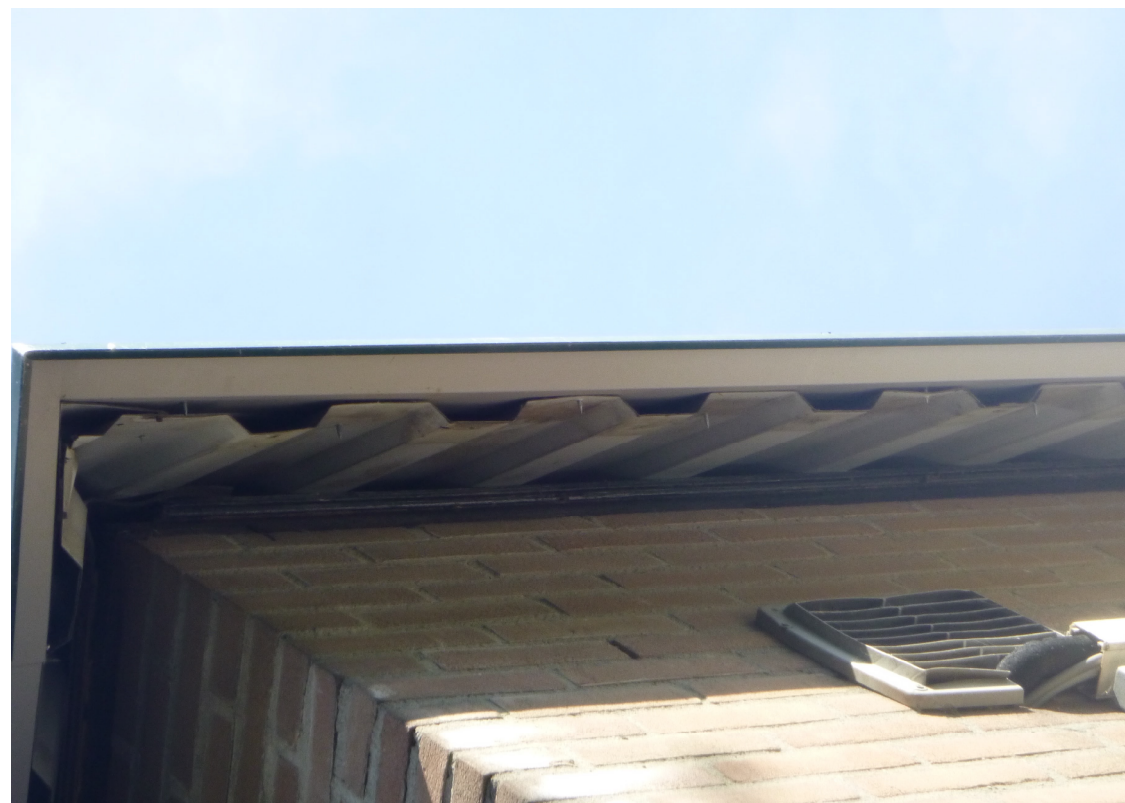
Foto detail gevel- en dakbeplating. Nieuwe enkelvoudige stalen sinus beplating rechtstreeks op alle bestaande damwand beplating geschroefd.
