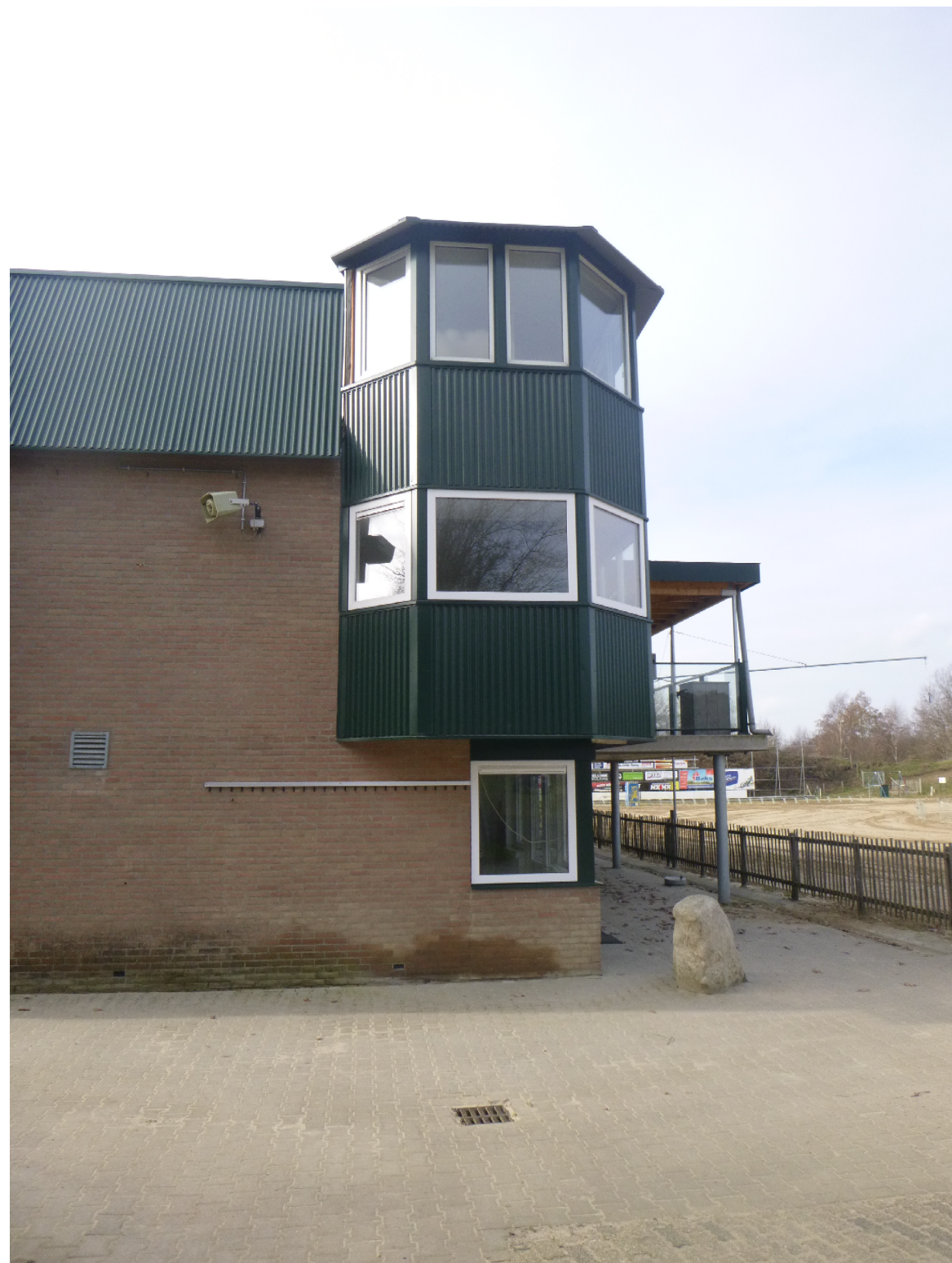
Foto linker zijgevel met enkelvoudige sinus beplating.
