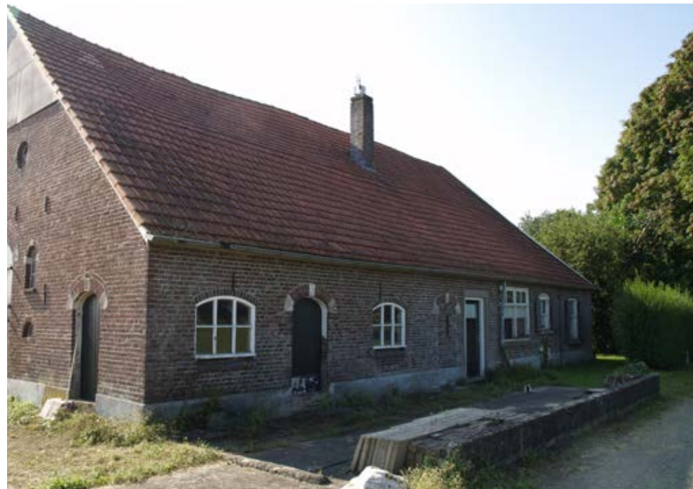
Oude boerderij, te verbouwen als woonhuis (gebouw 2)
