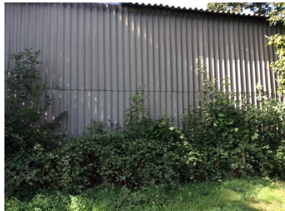
Figuur 11: Foto asbestdak zonder dakgoot
