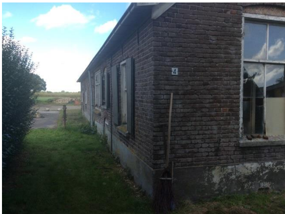
Figuur 10: Overzichtsfoto bebouwing
