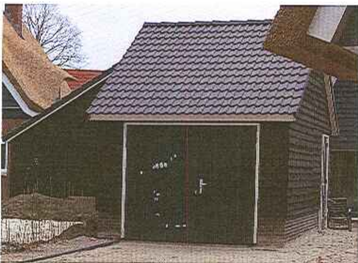
Schuur met kap en houten gepotdekselde muren (Twello)
