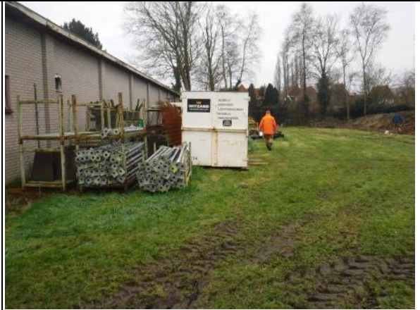
Overzicht zuidoostelijke terreindeel. Rechts de grondwal, links opslag van bouw materiaal naast bestaande bebouwing. Foto genomen in zuidelijke richting.
