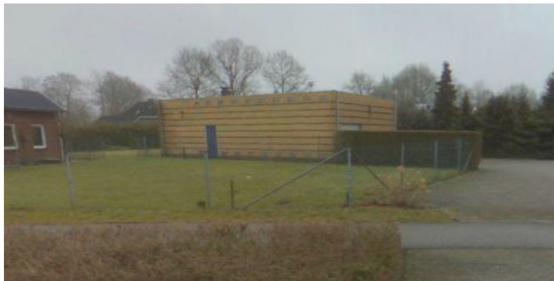
Locatie Lichtenvoordseweg (voormaligs nutsgebouw)
