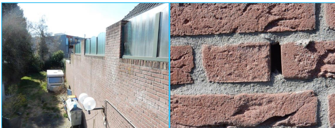
Foto's: Muur van de schuur met open stootvoegen.
