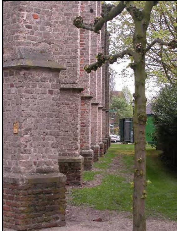
Steunberen van de zuidelijke gevel
