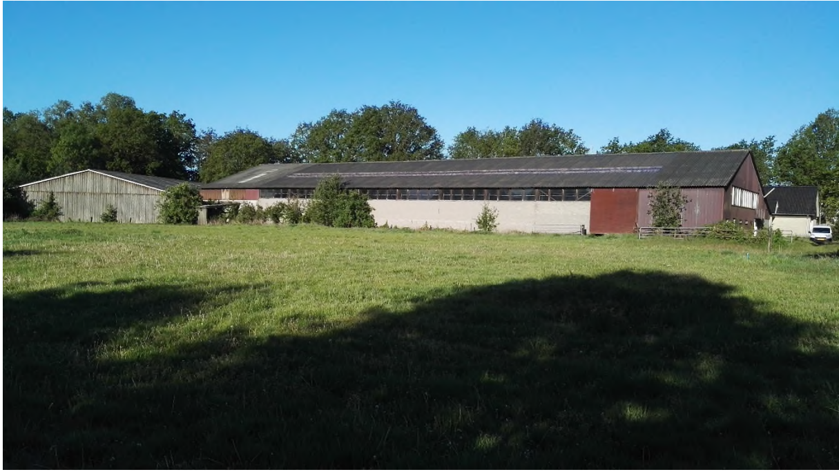
Figuur 13: Het weiland met op de achtergrond de grote rijstal en schuur gezien vanaf het noordoosten en gefotografeerd tegen het zuidwesten.
