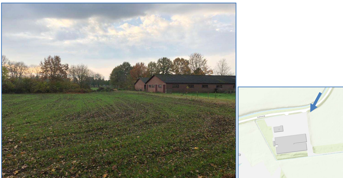
Afbeelding 6: zicht op de te slopen stallen vanuit noordoostelijk richting
