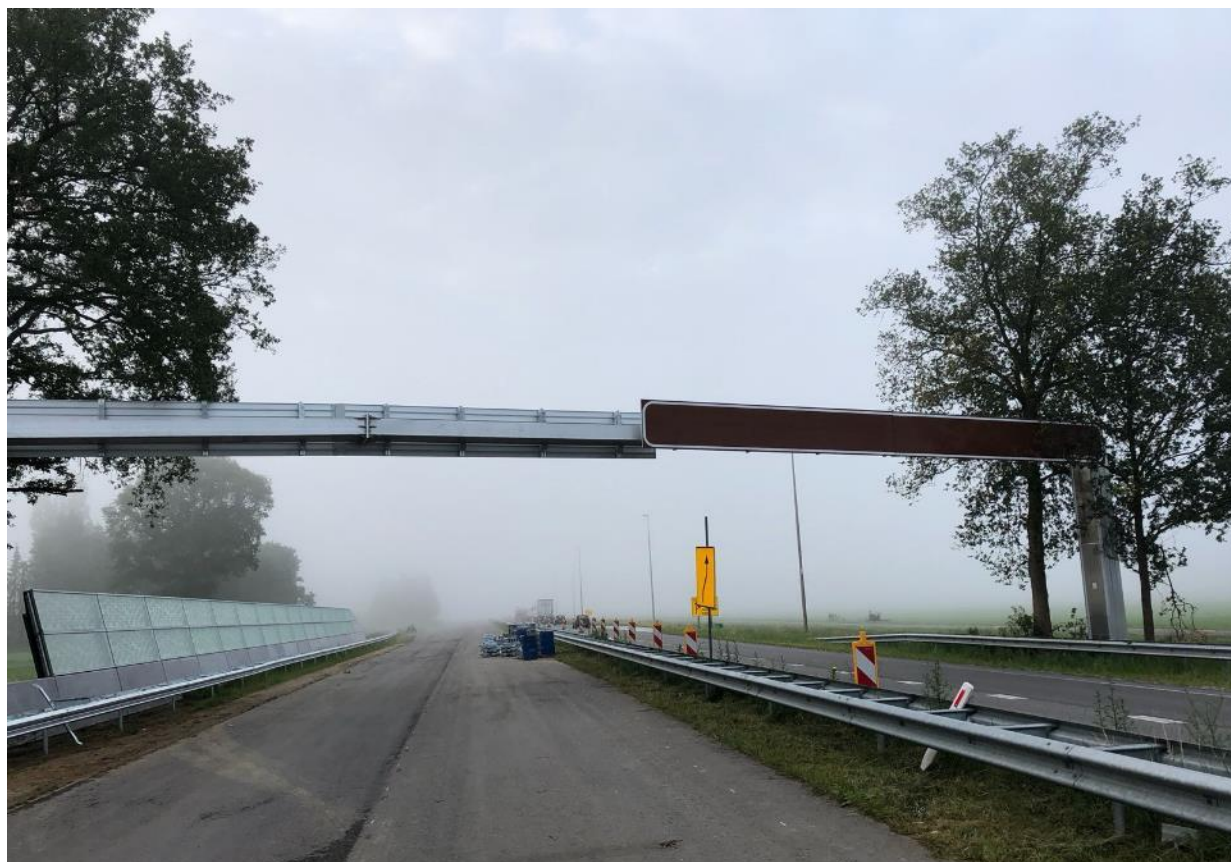
Figuur 4-2: voorbeeld van een aantoonbaar functionerend vleermuisportaal ter hoogte van de N35 bij Wijthmen (Bron: S. Bogaerts, Rijkswaterstaat).
