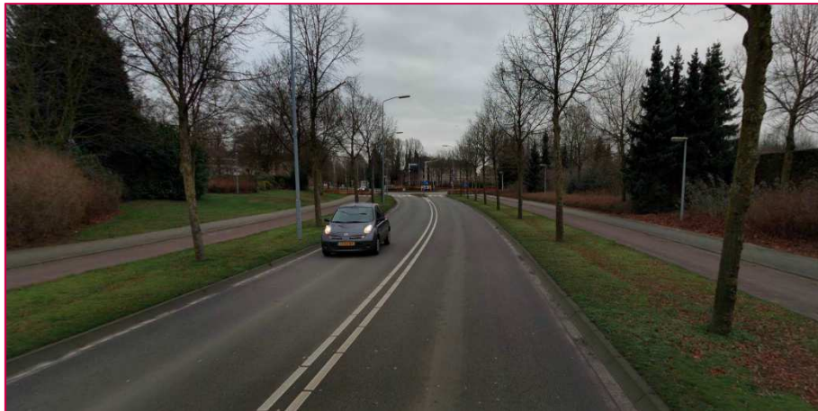
Figuur 5.3: Richterslaan (foto Cyclomedia)
