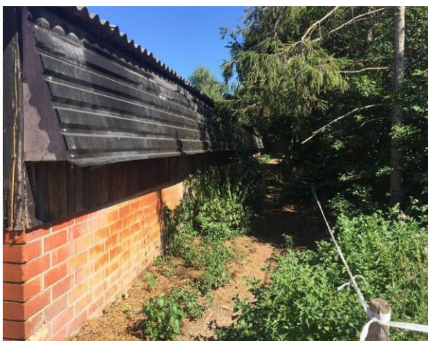
Figuur 8: Dak bebouwing
