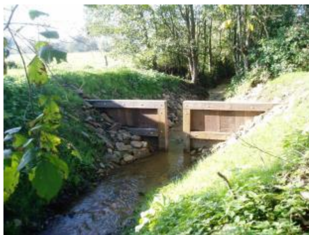
Figuur 12: Knijpstuw in de Vragenderbeek.
