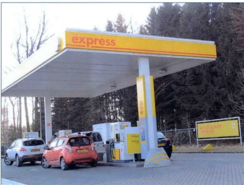
De bestaande Shell-pomp aan de Woudenbergsesweg (HV)
