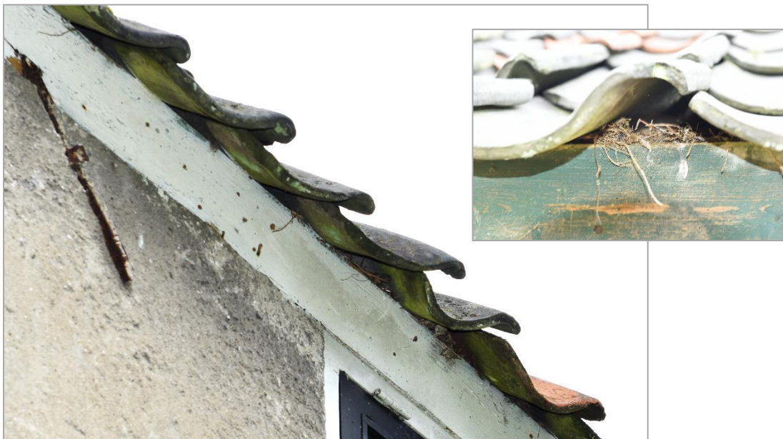
Figuur 11 en 12: ruimte onder de dakpannen met nestmateriaal
