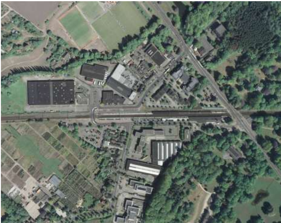
Afbeelding 3 Luchtfoto van recente situatie Station Driebergen Zeist (Foto uit google maps 2010)
