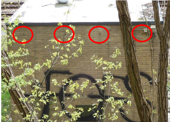
Figuur 6. Het relaishuis binnen het projectgebied bevat open stootvoegen (rood omlijnd).
