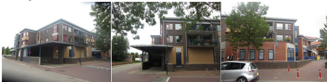
Afbeelding 4: Enkele foto's van de bestaande situatie.
