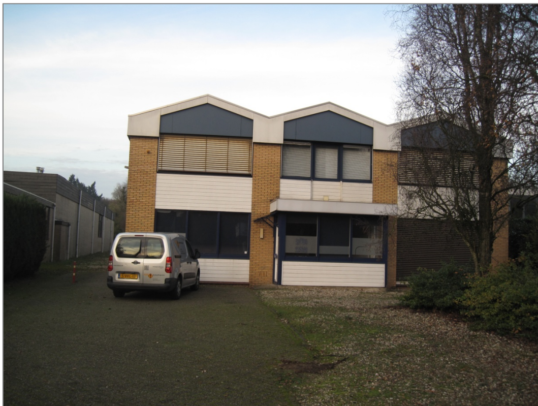
Afb. 4 Plangebied gezien in noordelijke richting vanaf de Middelweg
