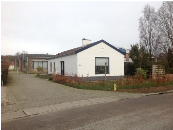
Middelweg 44 met oprit aan westzijde
