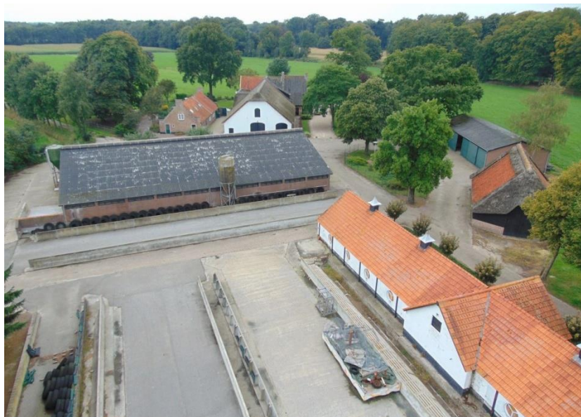
Afb. 57 Ligboxenstal met sleufsilo's en kuilvoerplaten, noordoostgevel
