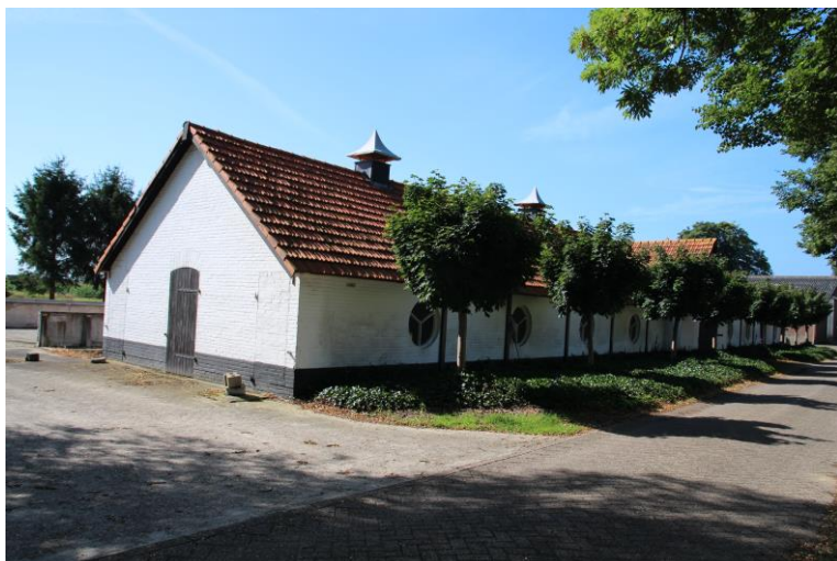
Kopgevel (noordoost) en langgevel (noordwest)
