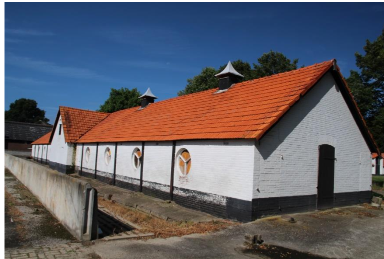
Kopgevel (noordoost) en langgevel (zuidoost)
