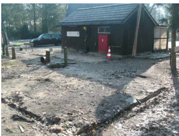
Foto 5: Locatie verwijderde schuur, met daarachter de noordwestelijke schuur
