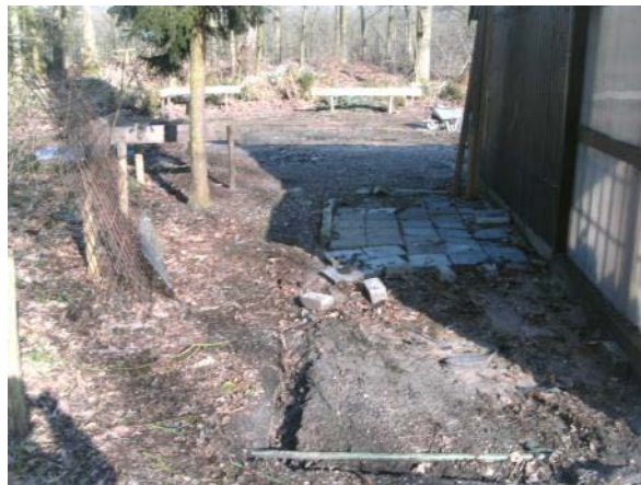
Foto 4: Verwijderde aanbouw noordwestelijke schuur
