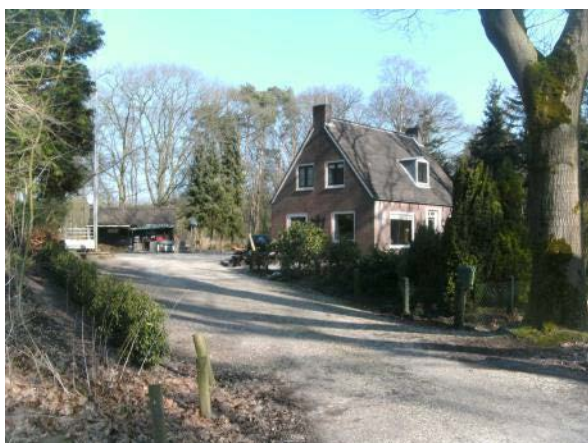
Foto 1: Woonhuis met achterliggende noordwestelijke schuur
