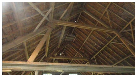
Dak van deel achterzijde
