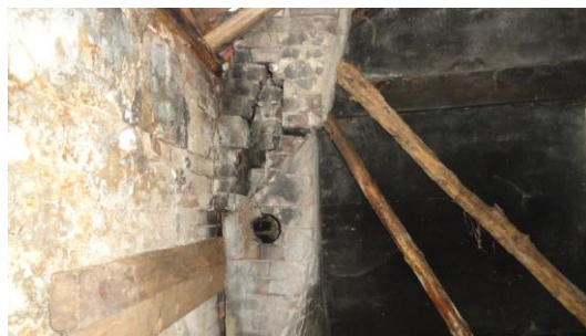
Schuur 4 schoorsteen (gemetseld)
