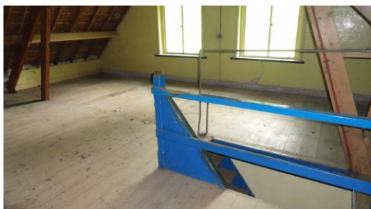
1 e verdieping (open ruimte)
