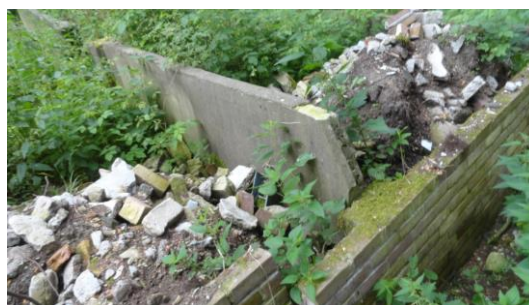
Stallen achterzijde schuur 3 (tussen puin geen verdachte materialen zichtbaar)
