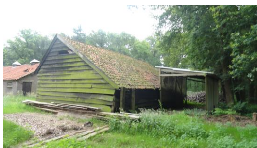
Overkapping achterzijde schuur 2
