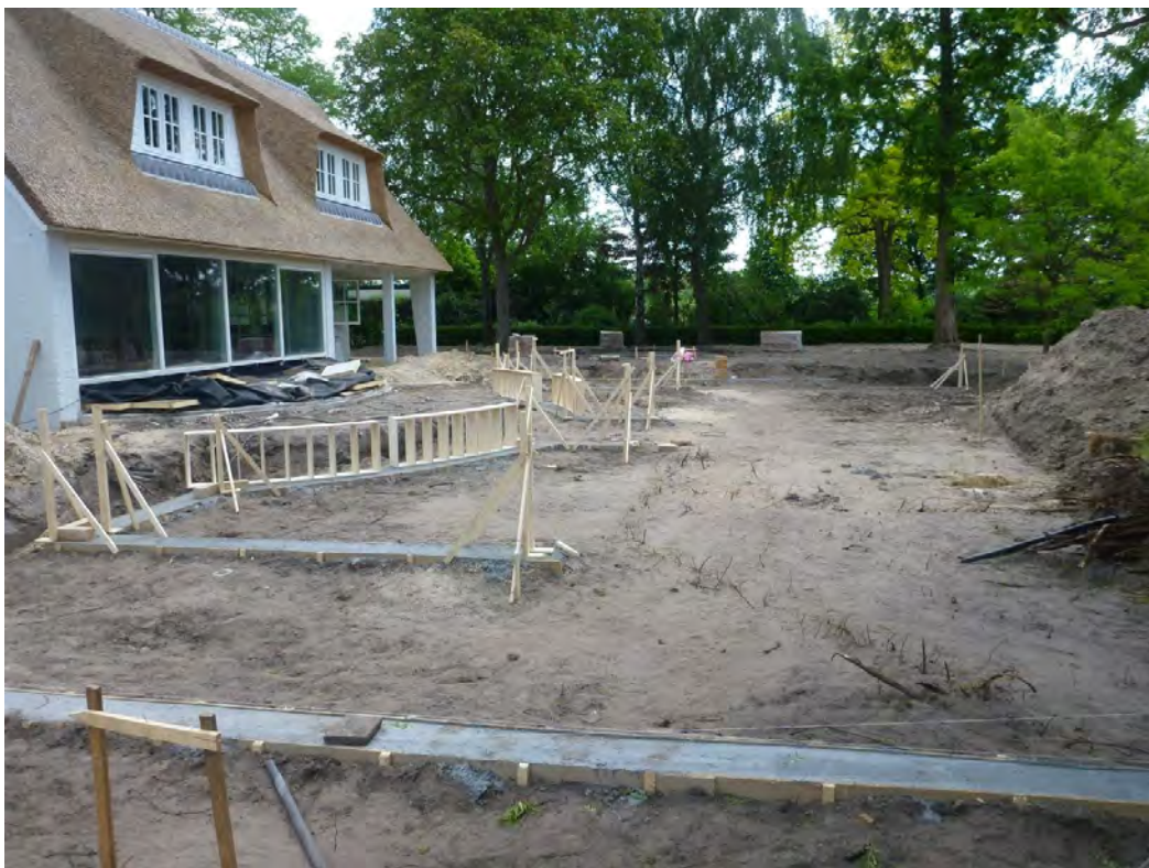
Fig. 3.3: Foto nabij boring 5 met verdiepte sleuf aan zuidzijde van woonhuis en de al ca. 50 cm diepe vergravingen voor de aanleg van de tuin.
