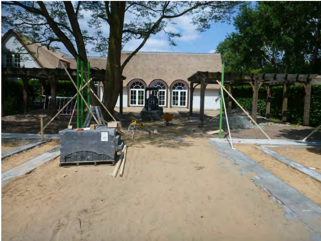
Fig. 3.4: De in aanleg zijnde siertuin nabij boring 6
