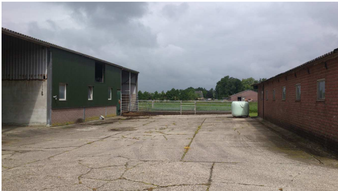
Afbeelding 1 Foto plangebied genomen in noordwestelijke richting ter hoogte van boring 2472005
