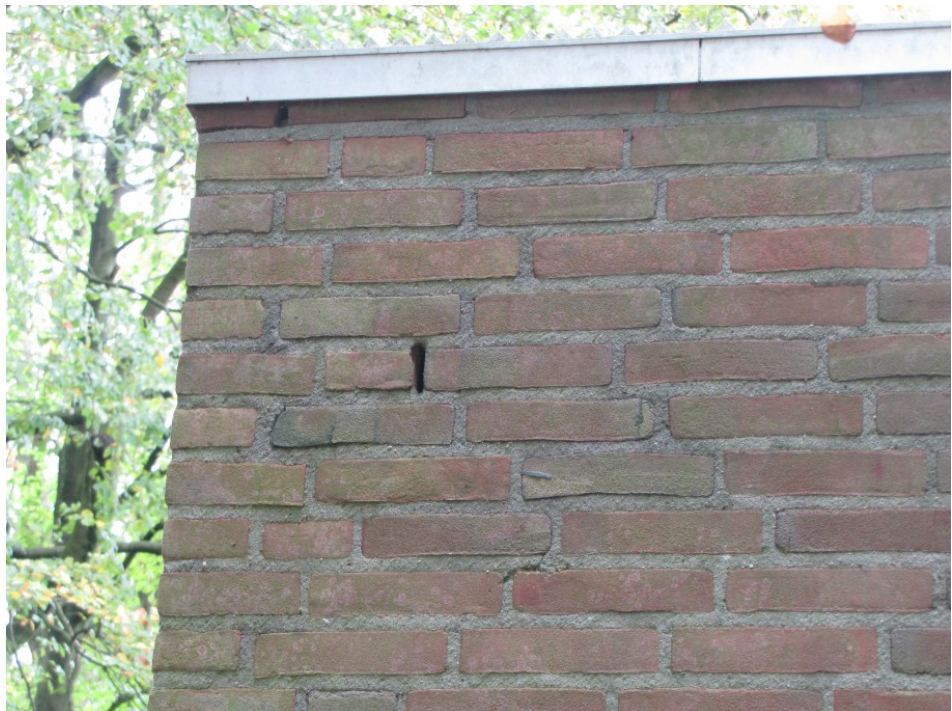
Figuur 7. Voor vleermuizen toegankelijke spouwmuur.
