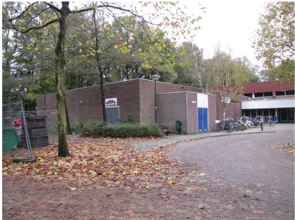
Figuur 3. Gebouw met plat dak, spouwmuur en houten betimmering.
