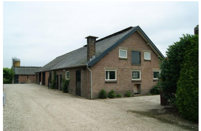
Zicht op te handhaven garage bij woning nr. 39 (links) en te slopen bebouwing (rechts)
