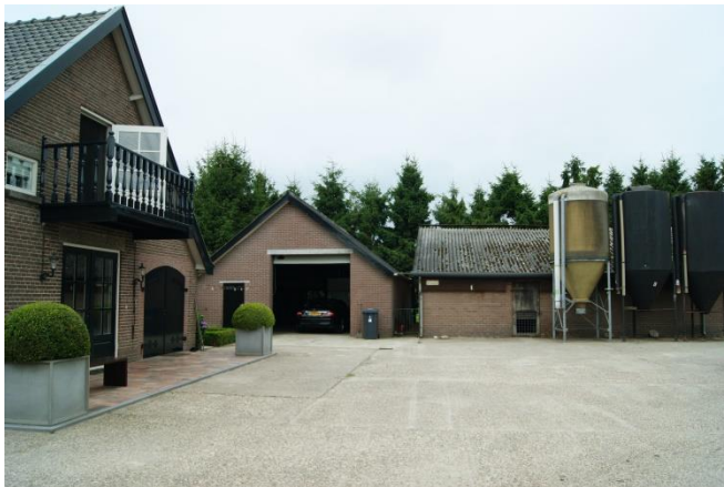
Zicht op te handhaven (voorste deel) bijgebouw bij woning nr. 39
