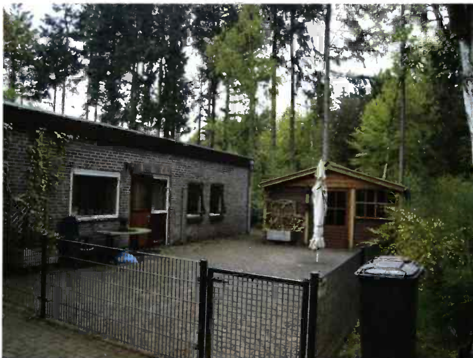
Foto 1. Ontluchtingspijp bij woning aan de Dr. Guttmanlaan 23
