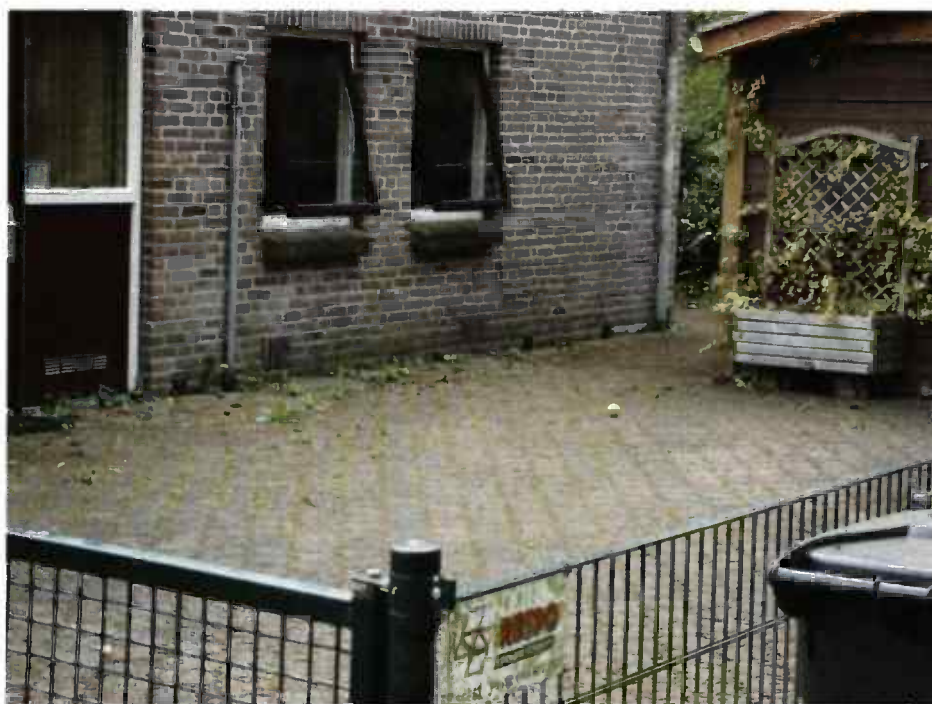
Foto 2. Close-up van de ontluchtingspijp
