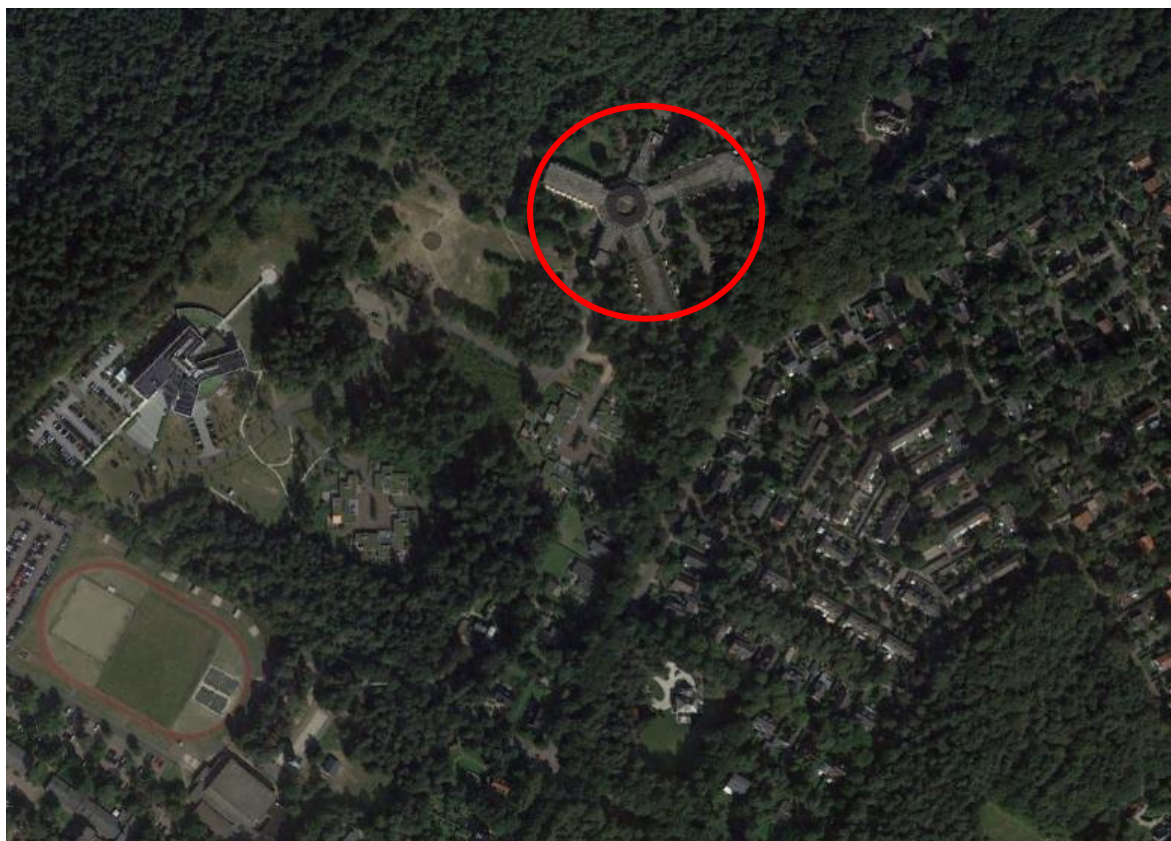
Ligging van te slopen spinvormig gebouw waar aanplant van bos zal plaatsvinden. Foto: Google earth
