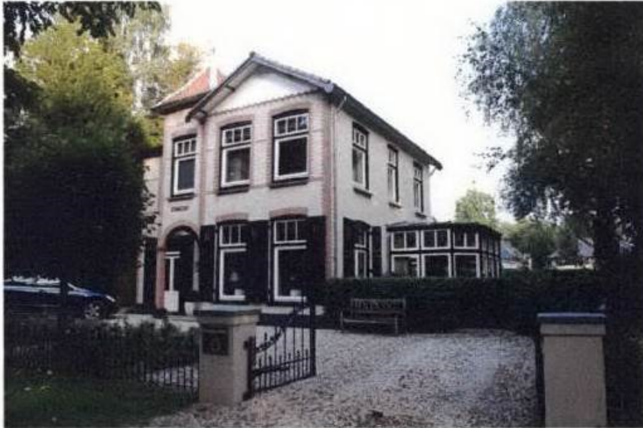
Figuur 3 foto's van voorgevel Drift 8 Doorn
