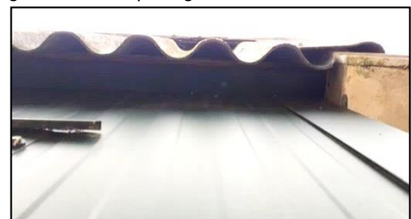
Figuur 10. Wandbekleding van onderaf gezien.
