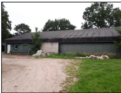
Figuur 3. De te slopen bebouwing.
