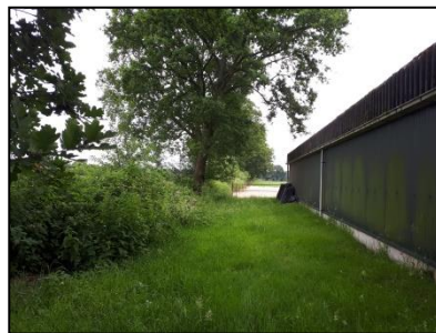
Figuur 4. Achterzijde (noordwest) bebouwing.
