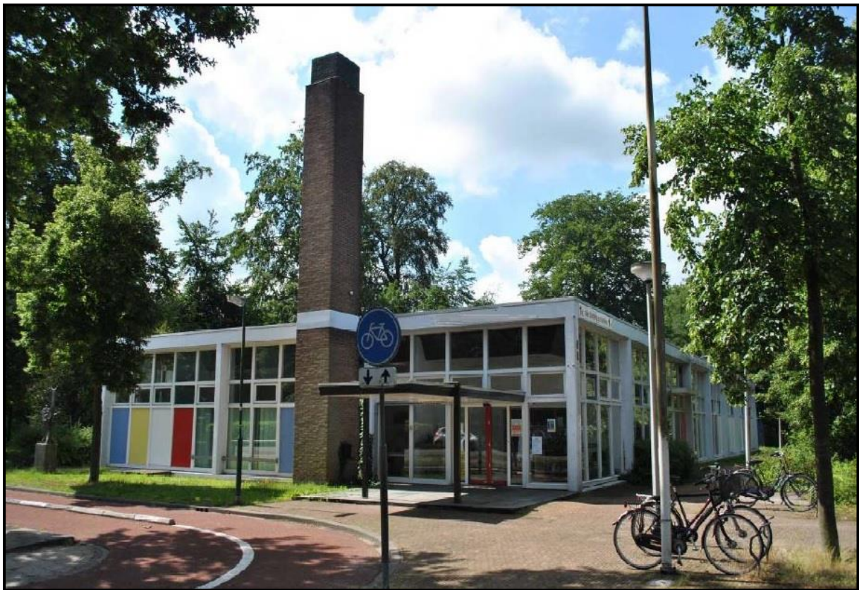
Foto Postkantoor voor de renovatie/verbouwing
