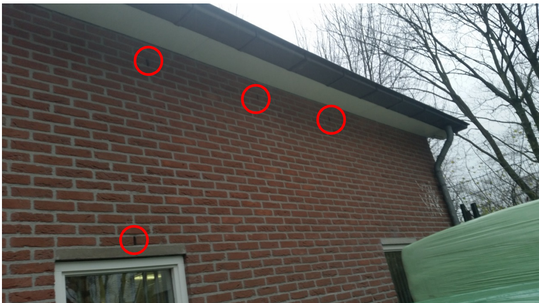
Figuur 6 Open stootvoegen zijn potentiële invliegopeningen voor gebouw-bewonende vleermuizen
