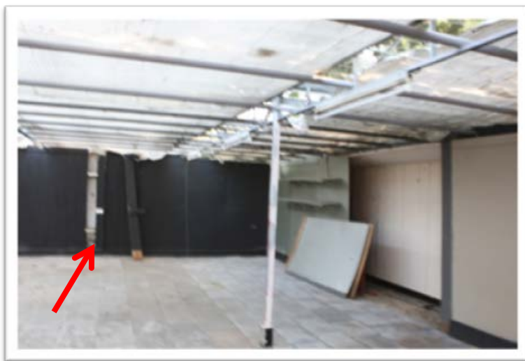
Beeld van de dubbele wanden in het voorste deel van de kas. Achter de losse plank bij de pijl werd een van de cameravallen geplaatst.
